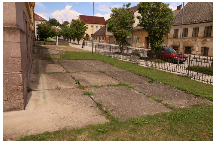
Betonové panely na rohu budovy ZŠ.
